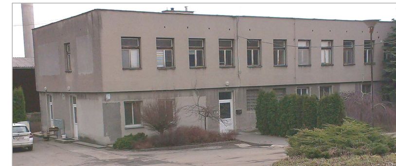
ADMINISTRATIVNÍ BUDOVA - STÁVAJÍCÍ STAV
